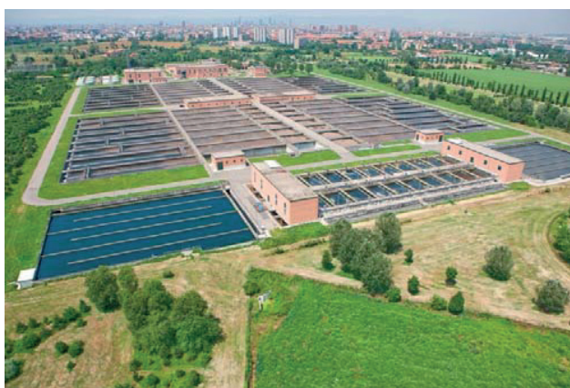
Nosedo Spildevandsanlæg, Milano
