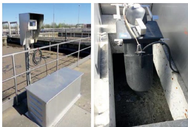
Figur 1: Signatur flowmåler med LaserFlow sensor med vejrbeskyttelse
